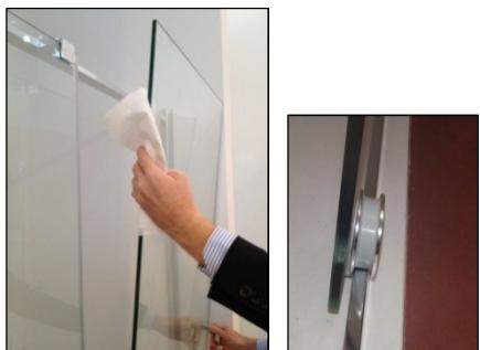
Lösen der Scheibe und Reinigung (muss nicht von der Laufschiene entfernt werden)
