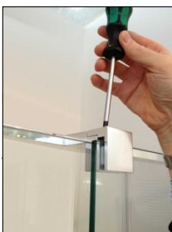
Gereinigte Scheibe an die obere Laufschiene anlehnen und Schraube fixieren
