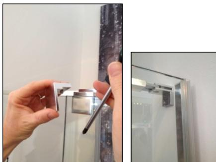
Entfernen der Stützenklemme – Schiebetür wird durch das Magnet gesichert
