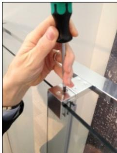
Lösen der oberen Schraube an der Stütze bei geschlossener Tür
